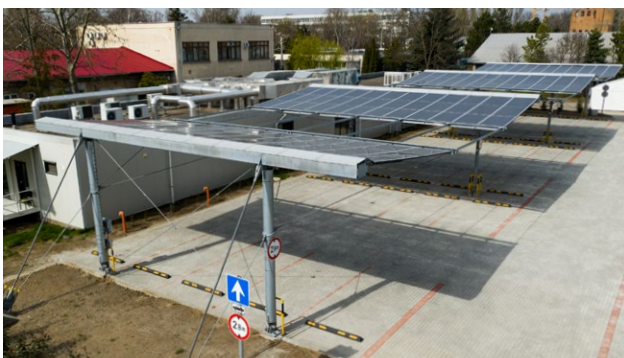
Abbildungen 8: Die Solarmodule könnten künftig auch mit schlanken Stützen und einem Seilsystem befestigt sein, was größere Spannweiten ermöglicht.
