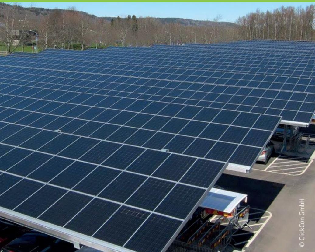
Die größte Parkplatz-PV-Anlage weltweit lässt sich derzeit in Biddinghuizen in den Niederlanden finden: Der 35 MW-Solarcarport mit 90.000 Solarpanels überdacht 15.000 Parkplätze eines Veranstaltungsgeländes, auf dem jährlich mehrere große Musikfestivals stattfinden. Der dort erzeugte Strom ersetzt den bisherigen Einsatz von umweltbelastenden Generatoren.
