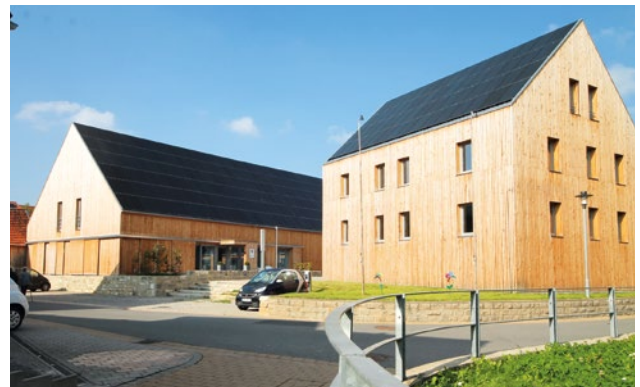
Bei diesem preisgekrönten Projekt in Weikersheim (Main-Tauber-Kreis) sind die Solarmodule in das Dach optisch integriert – eine ansprechende Lösung. Technisch ist dies eine klassische Dachanlage auf einem Trapezblechdach. Quelle: Architekturbüro Klärle Bad Mergentheim
