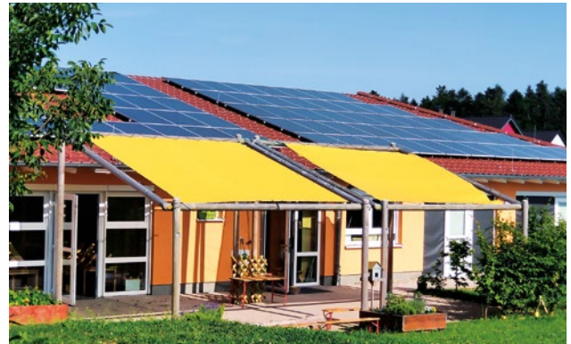
In Schömburg (Kreis Calw) wurden beim Neubau des Kindergartens alle geeigneten Dachflächen mit PV-Modulen belegt. Quelle: DGS
