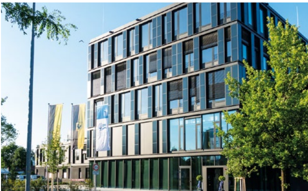
Im Neubau des ZSW in Stuttgart sind CIGS-Dünnschichtsolarmodule in die Fassade integriert. Die Module sind zwischen den Fenstern statt Alu-Abdeckungen platziert – auf diesem Foto sehr gut sichtbar, real kaum.
