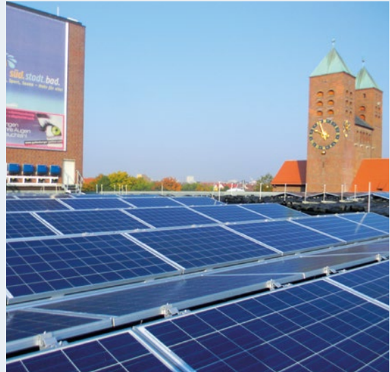
Photovoltaikanlagen-Miete in Nürnberg: Die Stadt mietet von der Bürgerenergiegenossenschaft die PV-Anlage auf dem SüdStadt-Bad und profitiert vom günstigen Strom.
