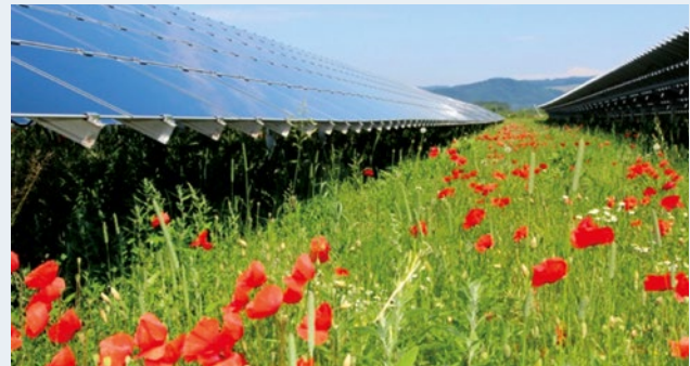
Im Solarpark Mooshof sind Solarenergie und Ökologie verbunden.
