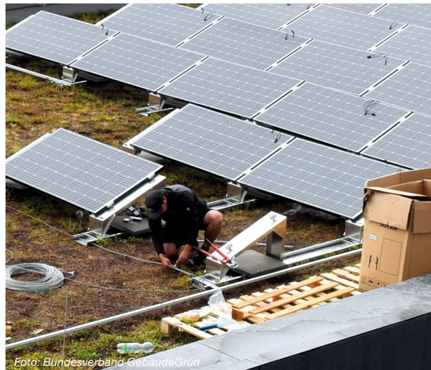
Abbildung 7: Montage einer PV-Anlage auf ein bestehendes Gründach.
